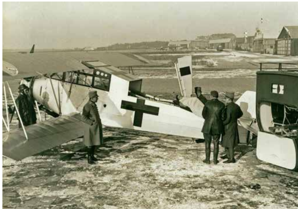
Het ambulancevliegtuig is een Fokker S.IIIa. Een omgebouwd trainingsvliegtuig een Fokker en was een open tweezitter waarbij de instructeur en leerling-vlieger naast elkaar zaten. In begin van de Tweede Wereldoorlog is deze gevorderd door de Duitsers.
